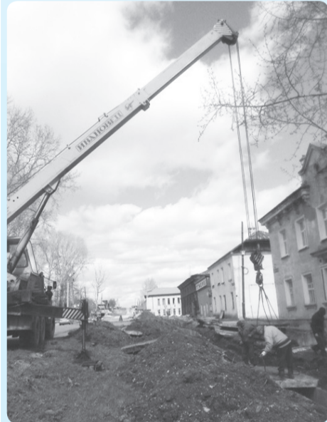
На фото: МУП «Тепловод» осуществляет замену труб на теплотрассе
